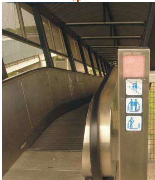
foto : rollend fietspad over de havenspoorlijn in Rotterdam. Kostprijs 2,25 miljoen euro.
